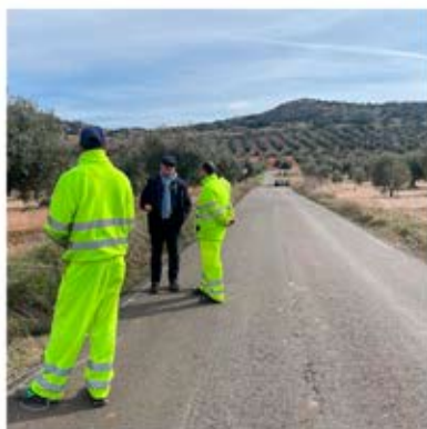
Tareas de pintura carretera Turleque
